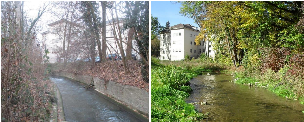
Abbildung 6: Ufergestaltung an der Ammer vor und nach der Umbaumaßnahme (Foto links: Ingenieurbüro Heberle; Foto rechts: Universitätsstadt Tübingen)
