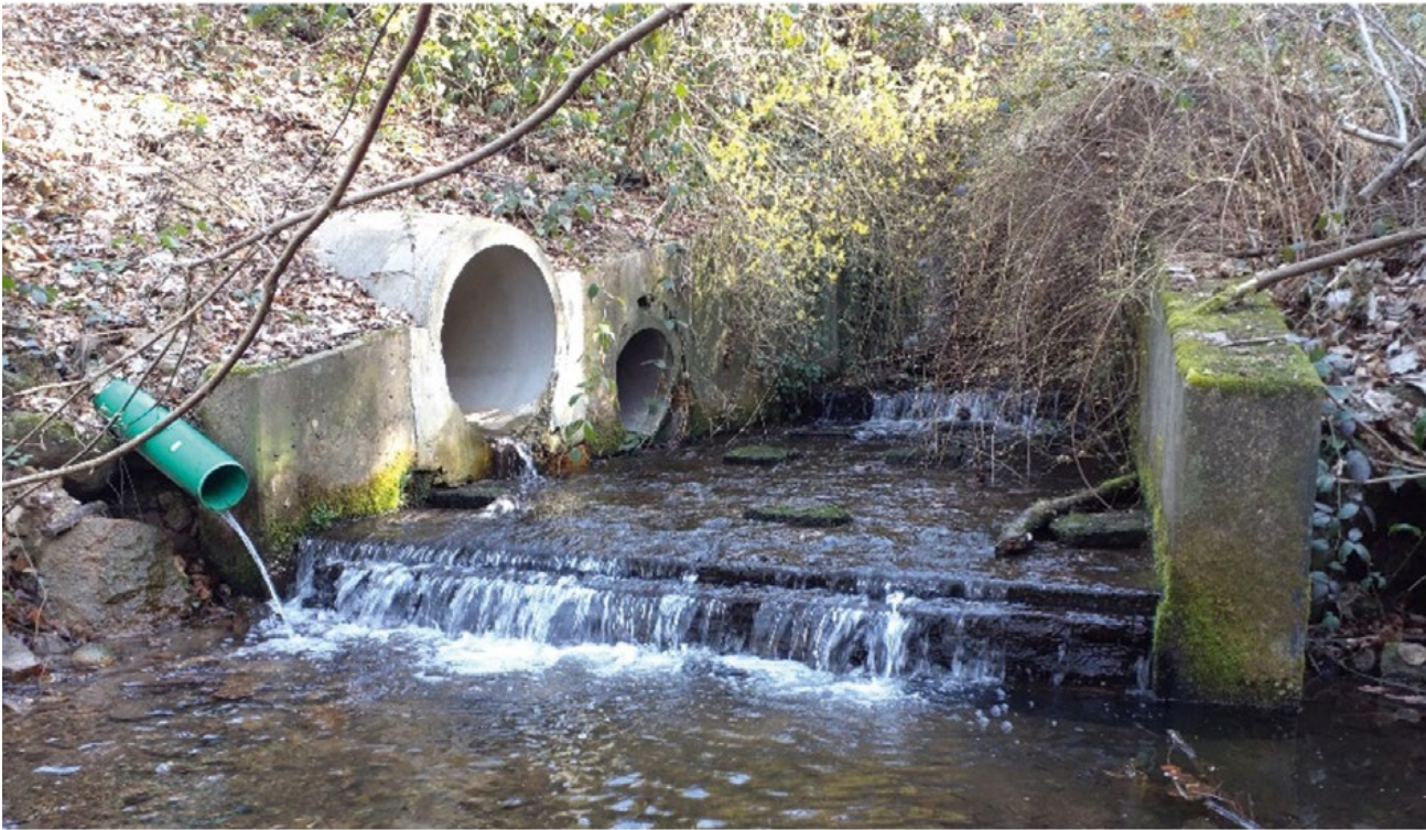
Abbildung 26: Beispiel für Querverbauungen: Abstürze hinter Rohren oder Schwellen können von vielen Bachorganismen nicht überwunden werden. So stellt für Groppen beispielsweise ein Absturz über zehn Zentimeter Höhe bereits eine Wanderungsbarriere dar. © Anhäuser
