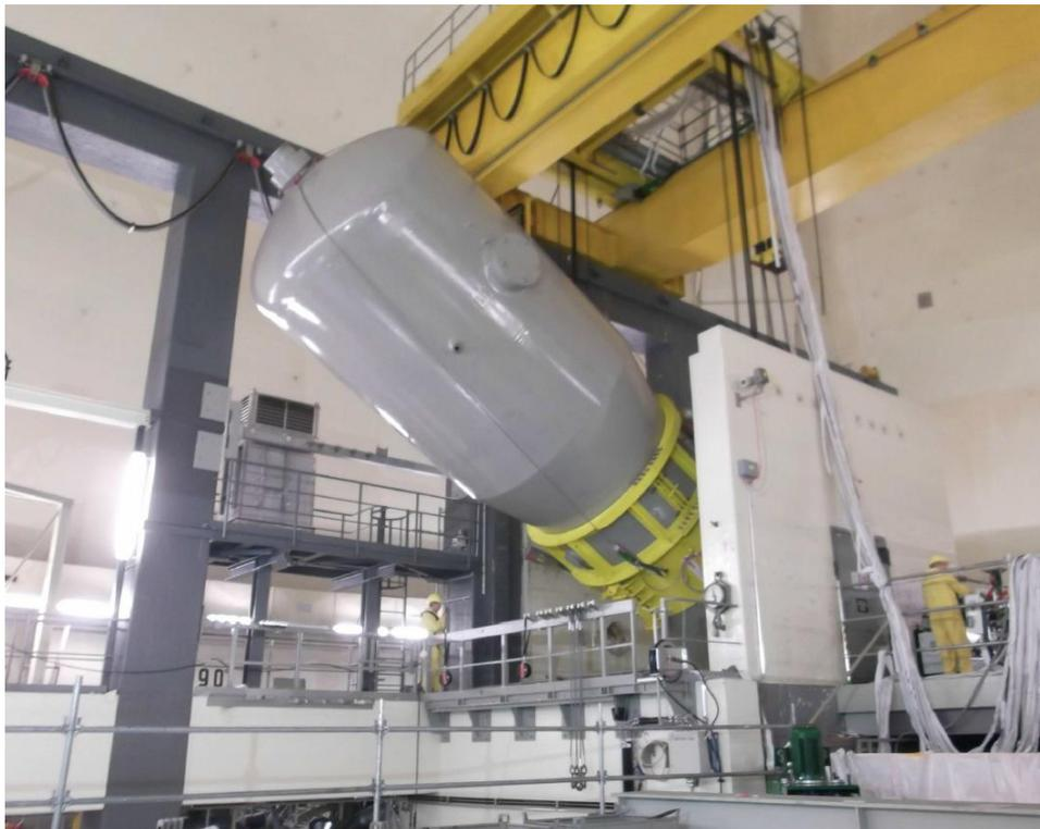
**Ausbau des Dampferzeugers im Kernkraftwerk Obrigheim**
