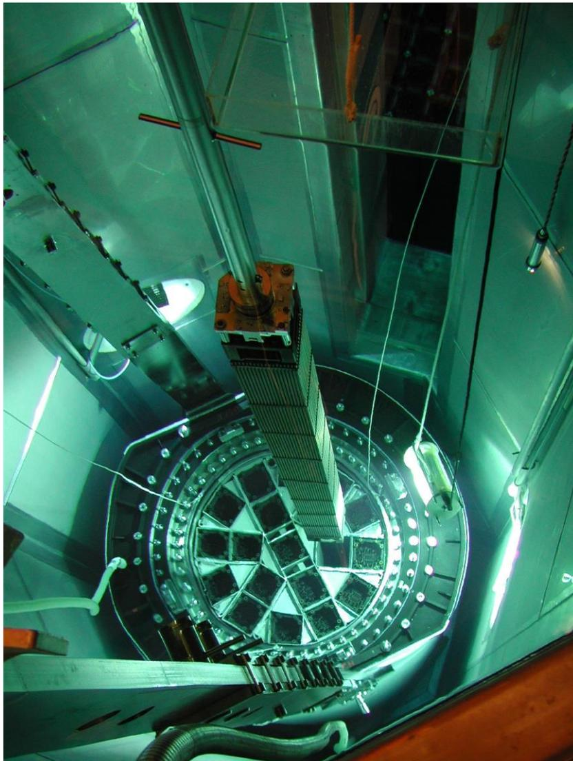
**Beladung eines CASTOR-Behälters mit einem Brennelement
