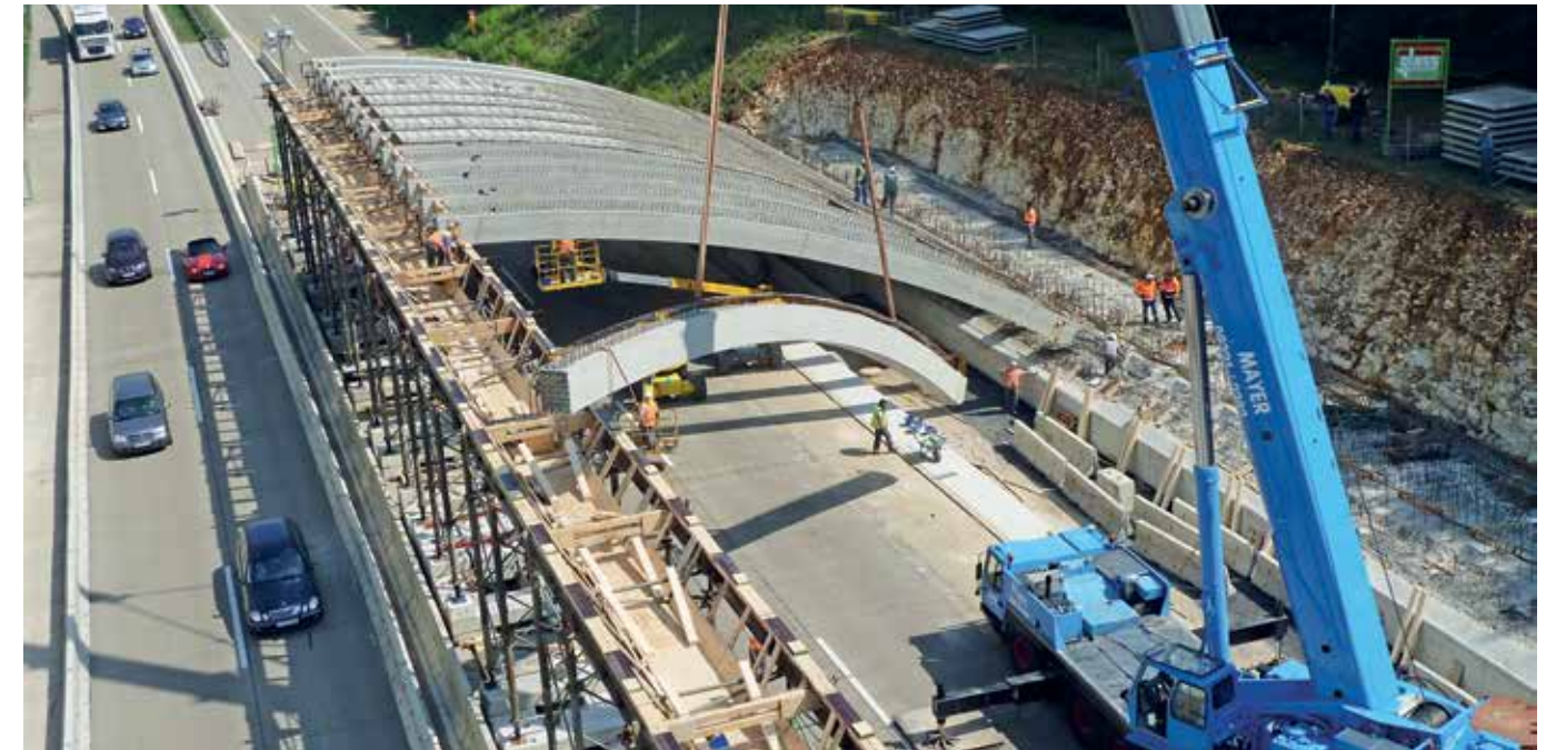
Grünbrücke über die A7 während des Baus
