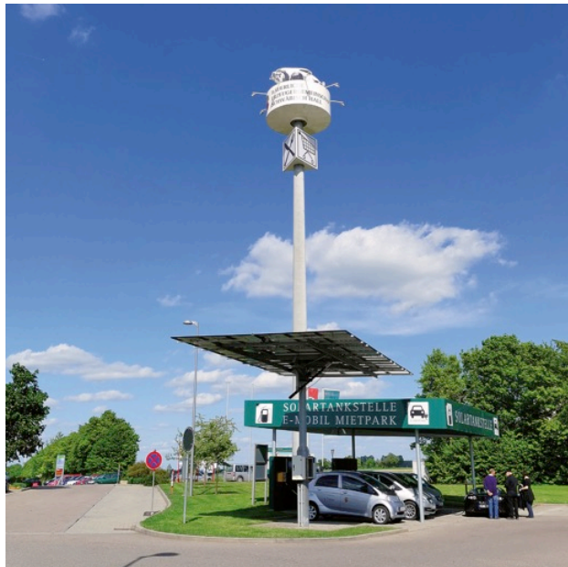
Abbildung 1 - Solartankstelle der Modellkommune für Elektromobilität im Ländlichen Raum, Wolpertshausen; Quelle: Ministerium Ländlicher Raum und Verbraucherschutz Baden-Württemberg
