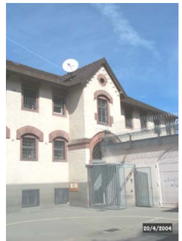
JVA Rottenburg, Außenstelle Tübingen, Baujahr 1905, unter Denkmalschutz.
