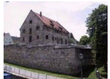
JVA Rottweil, Baujahr 1860, unter Denkmalschutz
