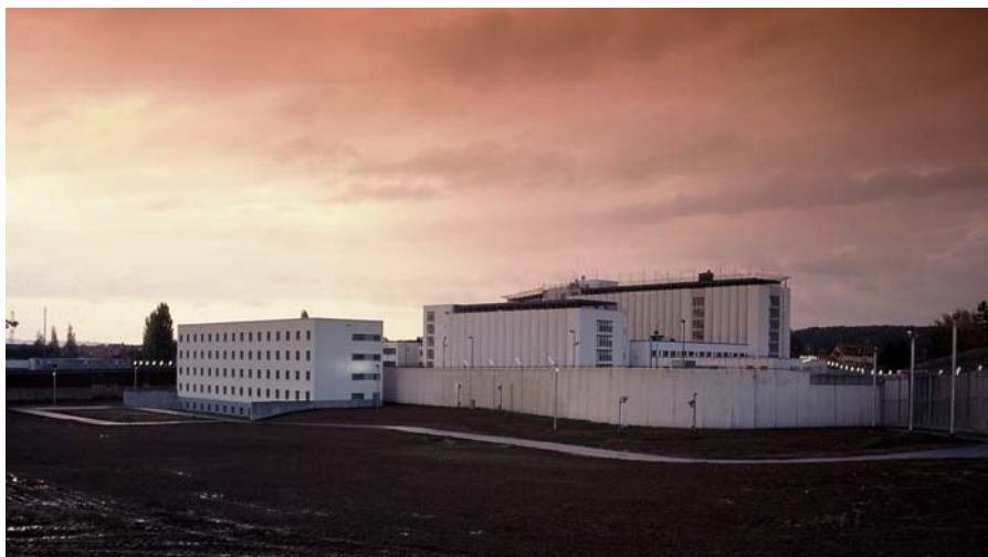
JVA Stuttgart-Stammheim, rechts Bauten um 1960, links Bau 3, Fertigstellung 2004
