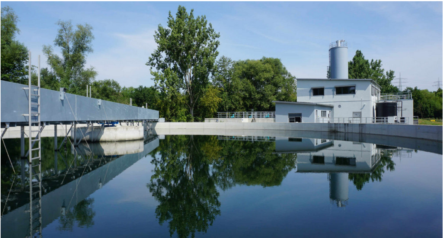
© Gruppenklärwerk Wendlingen am Neckar
