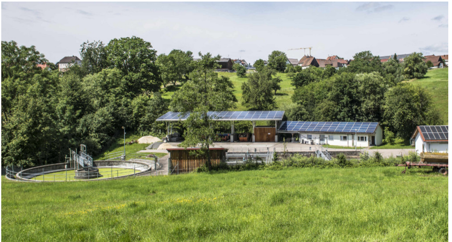
Kläranlage in Spraitbach
