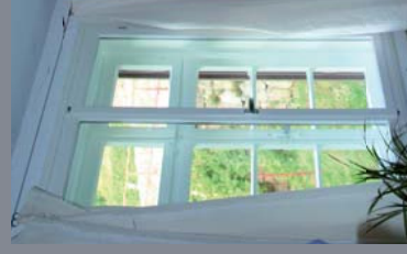
Umbau, Einfachfenster zu einem Verbundfenster
