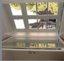
Historisches Einflächfenster mit Isolierverglasung und Kastenfenster
