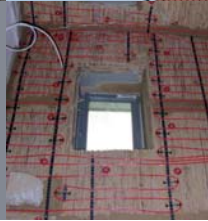
Innenputz mit integrierter Wärmehitzung
