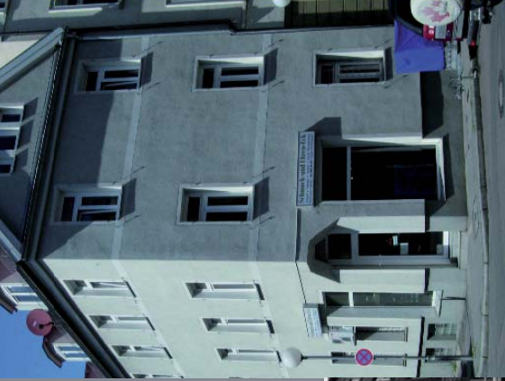
Bauwerk der 30er Jahre, Sanierung der Fenster und Ergänzung zu Verbundfenstern, neue Heizanlage und Einsatz einer solarthermischen Anlage auf der Terrassenüberdeckung
