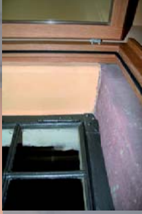
Ehem. Heizhaus, heute Wohnhaus, Erhalt der Eisenfenster und Ergänzung mit isolierverglästen Kastenfenstern in der Ebene des Wärmedämmputzes
