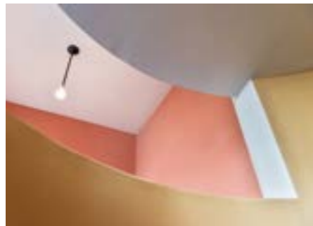
Doppelhaus: Treppenhaus, Le Corbusier/Pierre Jeanneret Semi-detached house: Stairwell, Le Corbusier/Pierre Jeanneret
