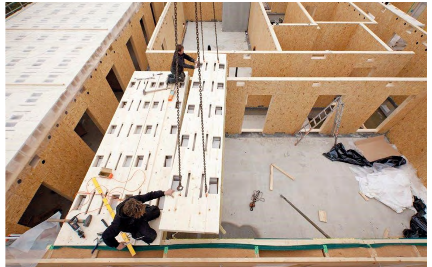
Montage eines Gebäudes in Holzrahmenbauweise (Quelle: Weizenegger GmbH)
