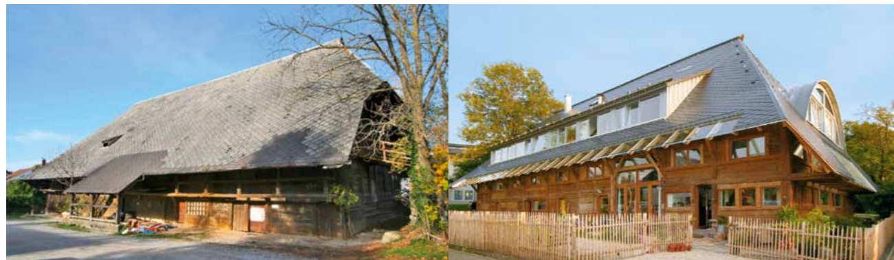
Vorher – nachher: Die denkmalgeschützte ehemalige „Birkenhofscheune“ in Kirchzarten-Burg (Baujahr 1790) wurde ursprünglich landwirtschaftlich genutzt; hier befanden sich Ställe, Tenne und Heulager. 2005 wurde sie von sutter 3 komplett um- und ausgebaut, wobei die Grundgestalt des traditionellen Schwarzwälder Bauernhauses außen wie innen in vielen Details beibehalten wurde. Trotz der Architektur aus Glas, Stahl und Beton ist der ursprüngliche Holzbau aus Birke durchgehend präsent. Heute beherbergt das Gebäude neben der „Birkenhof-WG“ für demenziell erkrankte Menschen auch die Kinderstube Dreisamtal sowie Wohnungen für Familien.
